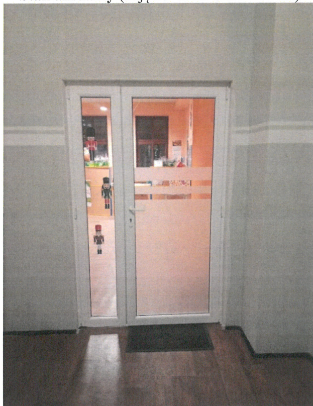
Stan aktualny (zdjęcie arch. MBP 2024 r.)
